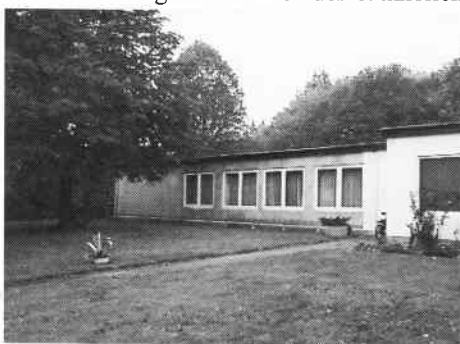
Das Vereinsheim - noch mit Flachdach
